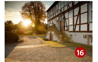
Mallinckrothhof Das ehemals herrschaftliche Fachwerkgebäude, von einem Wassergraben und Park umringt, wurde 1684/86 errichtet.
