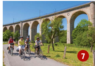
Großer Viadukt Der 482 Meter lange Große Viadukt, die größte steinerne Eisenbahnbrücke Europas, überspannt mit 24 Bögen das Beketal.
