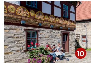
Spieker Atteln Das 1588 erbaute Fachwerkhaus diente einst als Amtshaus und gilt heute als ein Juwel der Weserrenaissance-Architektur.
